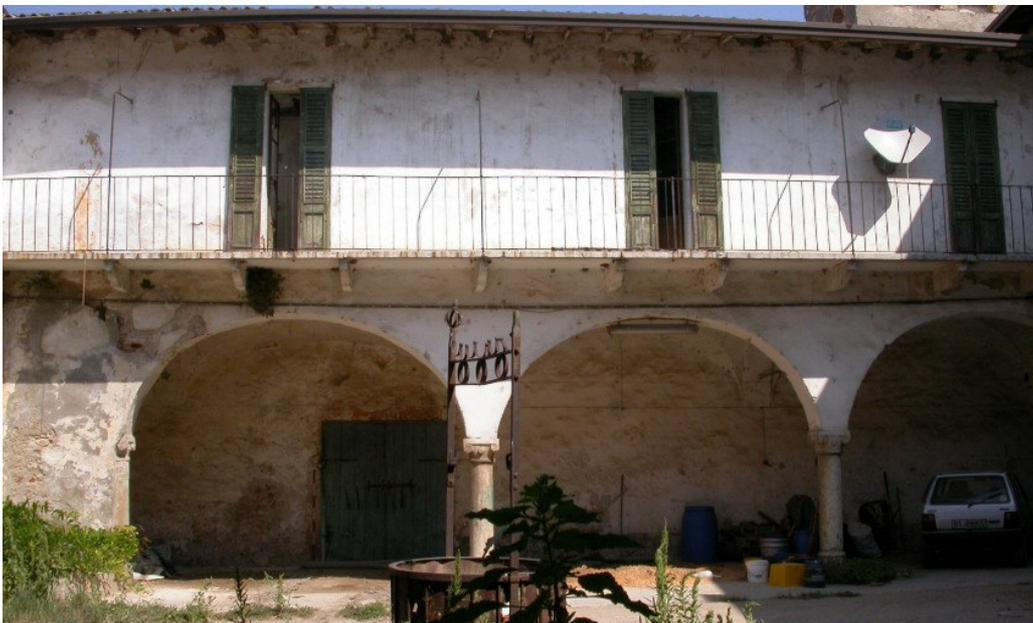
Complesso costituito da due corti rurali. Il nucleo originario era costituito da un porticato ad archi sorretto da colonne di marmo, risalente al XV secolo, oggi in avanzato stato di degrado a causa di recenti atti vandalici. All'interno dello stesso corpo di fabbrica si conservano tracce della chiesa romanica del monastero medievale. Lungo gli altri due lati della corte si sviluppa un'ampia casa padronale risalente al XIX secolo.
