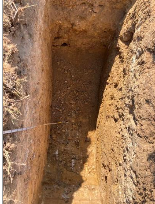
Scavo esplorativo T1
