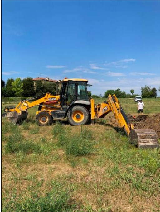
Postazione scavo esplorativo T3
