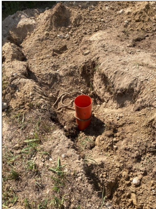
Fig. 5 - Esecuzione di prova di permeabilità in sito.
