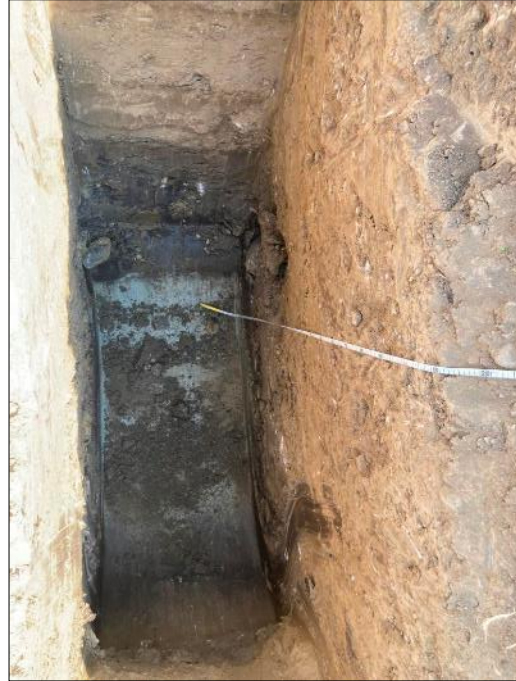
Scavo esplorativo T3
