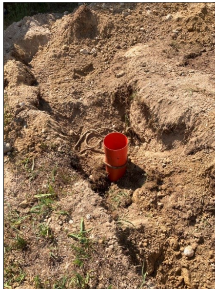
Fig. 3 - Esecuzione di prova di permeabilità in sito.
